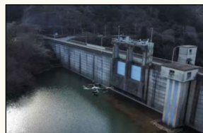
ダム点検管理のローカル 5G実証 実験
