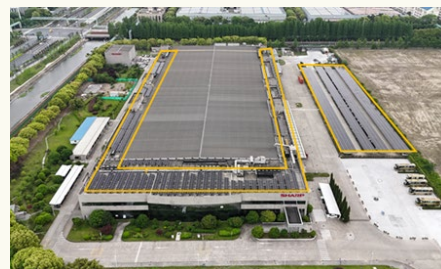
太陽光発電設備
