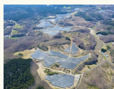
鯨川青生野太陽光発電所
