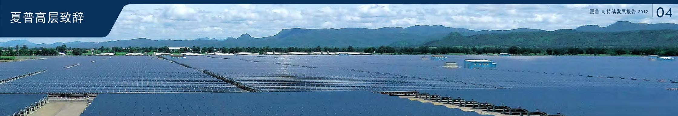
2012年3月在泰国建成的、装有夏普产薄膜太阳能电池的世界最大规模的73MW兆瓦太阳能发电站(夏普公司接到泰国独立发电事业公司NED公司订单,与泰国最大建筑公司ITD公司/ITE公司共同建造,夏普同时还承接了维修保养业务。)
